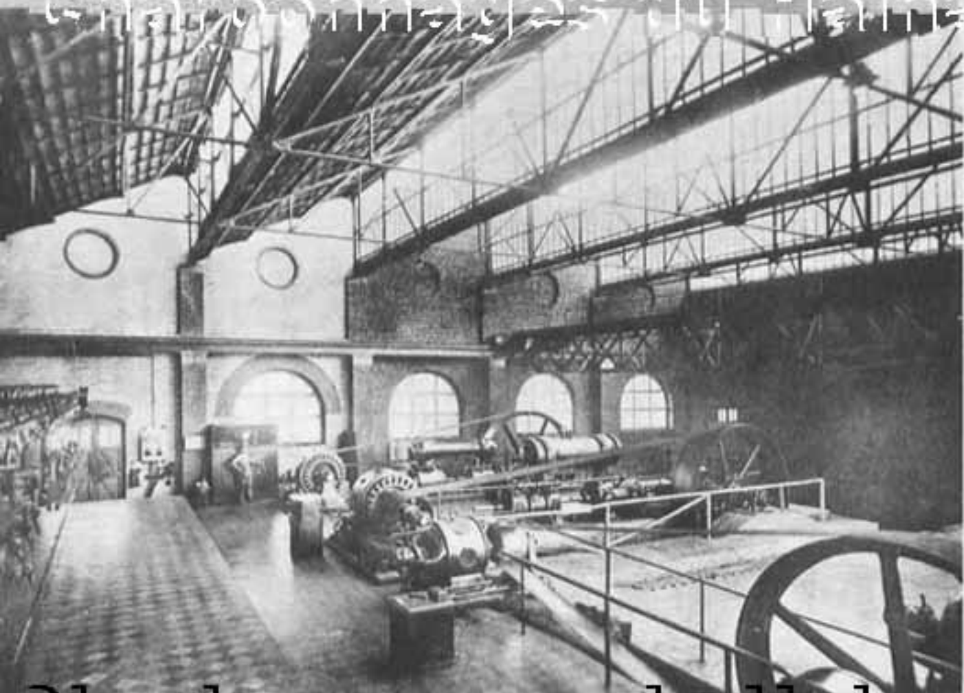
CHARBONNAGES DE MAURAGE Salle des compresseurs et ventilateur (Puits Marie-José)
